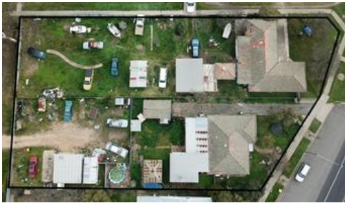
2-4 Ararat Rd, Stawell
